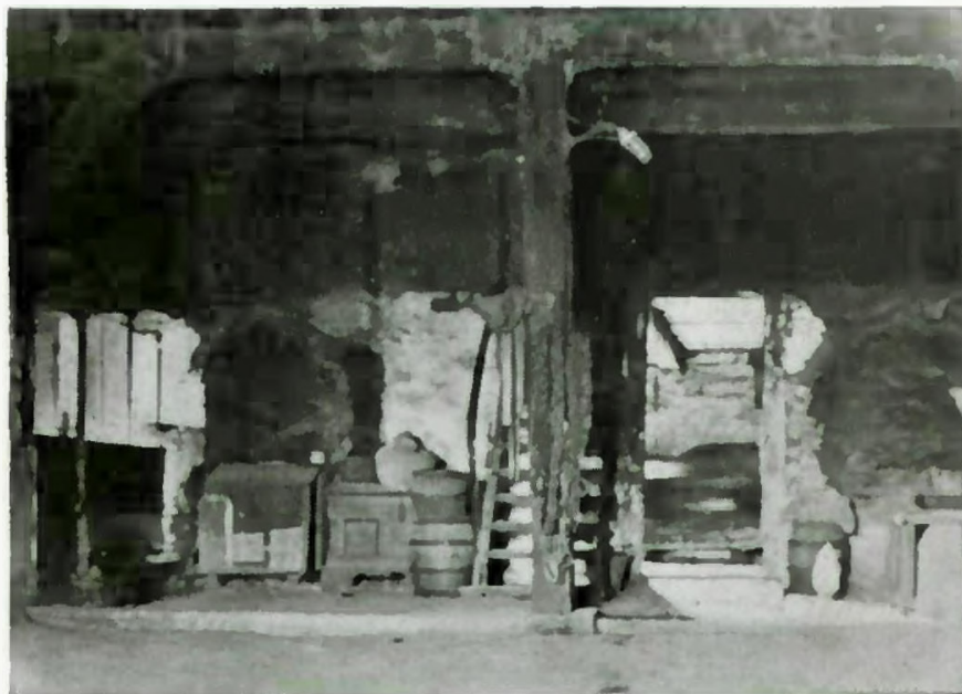
Der Pfeiler an der Flettgrenze. (An der Stubenwand die rauchgeschwärzte Stelle der abgebrochenen Schwibbogen.)
